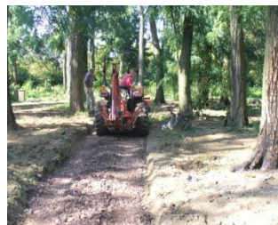
Výkop ryhy pre chodník a navázanie mletého kameňa
