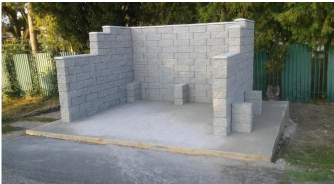
Začatá rekonštrukcia autobusových zastávok. Foto: O. Sabolová
