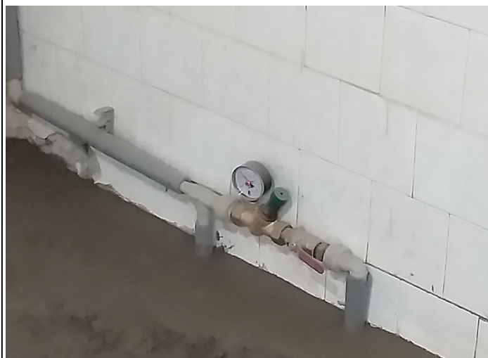
Prestavba bývalej kuchyni
